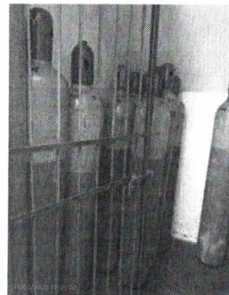
Foto 49 - Cilindros de cloro
