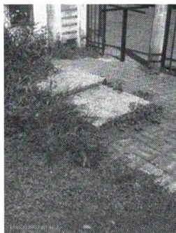
Foto 20 - Tampa de concreto cobrindo o poço
