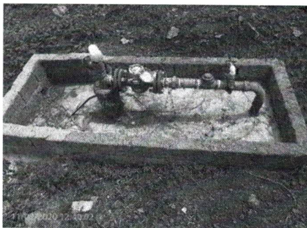
Foto 15 - Laje de proteção
