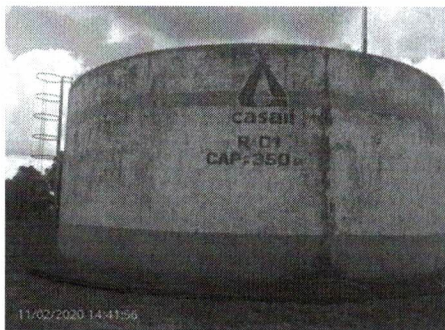
Foto 103 - Estrutura civil do reservatório
