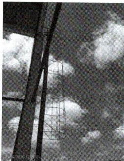
Foto 133 - Escada de acesso
