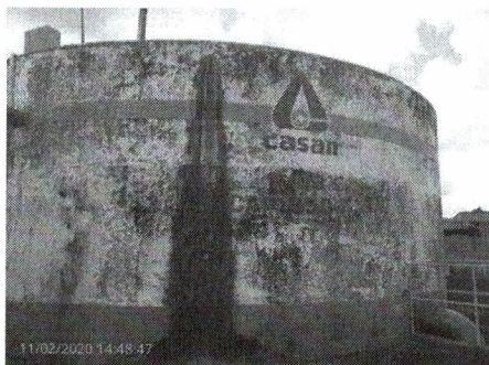
Foto 110 - Estrutura civil do reservatório
