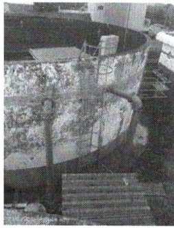
Foto 116 - Escada de acesso
