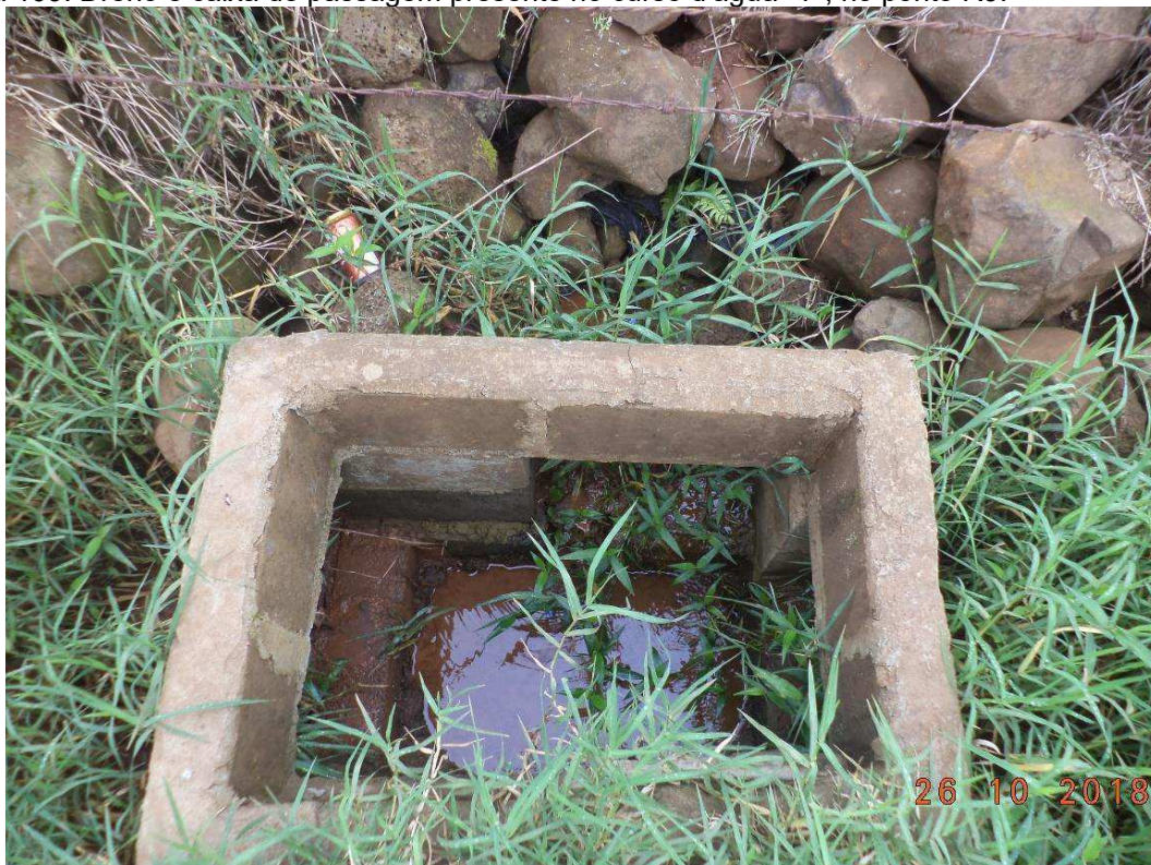
Figura 109: Dreno e caixa de passagem presente no curso d'água "Y", no ponto R9.
