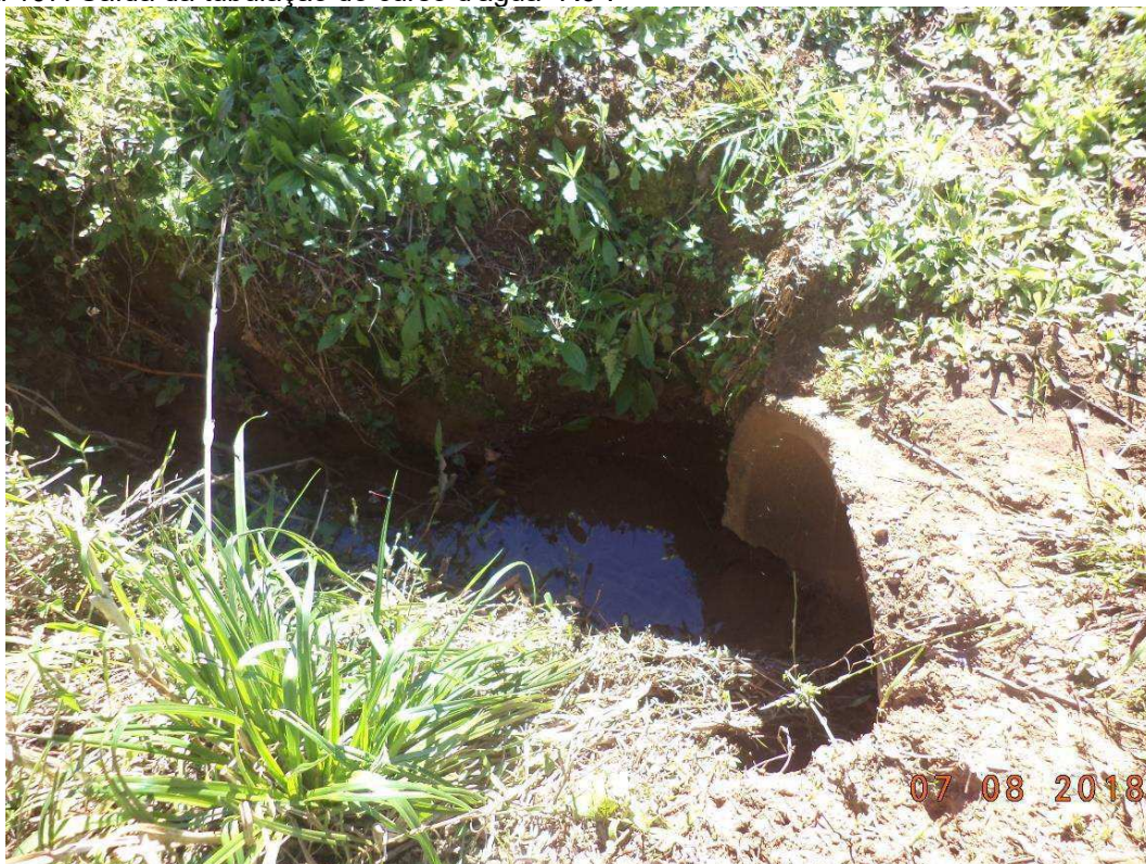
Figura 107: Saída da tubulação do curso d'água "R6".
