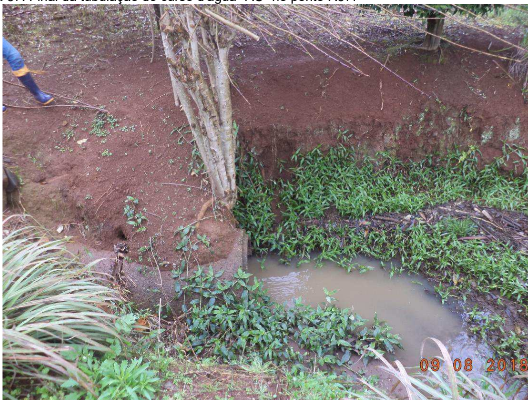
Figura 87: Final da tubulação do curso d'água "AC" no ponto R37.
