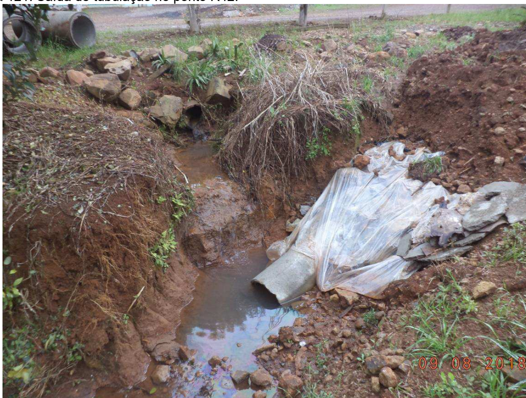
Figura 121: Saída de tubulação no ponto R42.
