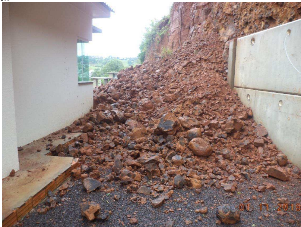
Figura 58: Queda de blocos ocorrida durante as chuvas de outubro de 2018, no ponto RG01, no bairro Flor.
