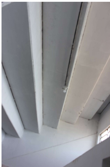
Remoção de todas as lâmpadas e instalação de novas lâmpadas LED
