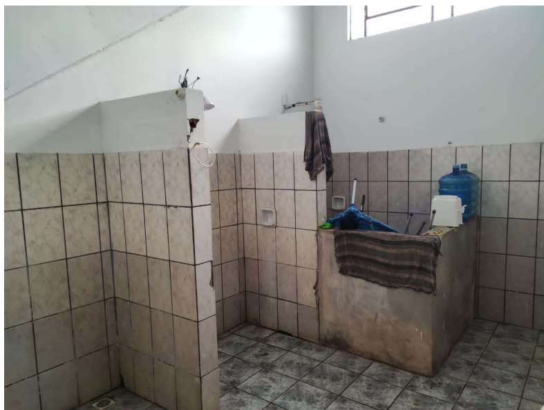
Remoção de todo o revestimento cerâmico, louças, metais e chuveiros
