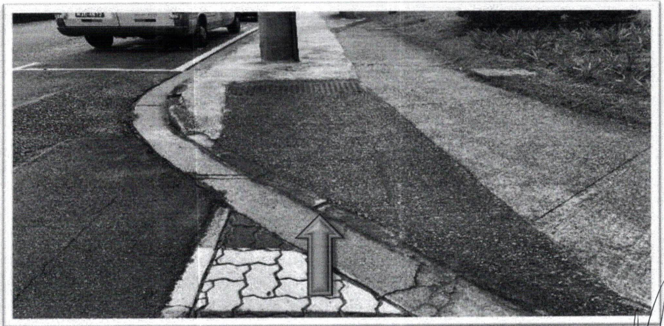
Figura 3 - Rebaixo de guia e piso tátil na calçada externa
