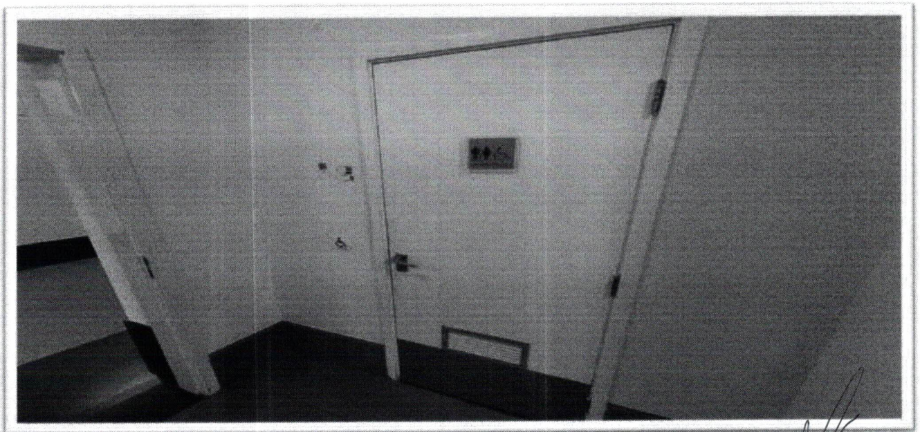
Figura 15 - Sanitário acessível do 8º pavimento
