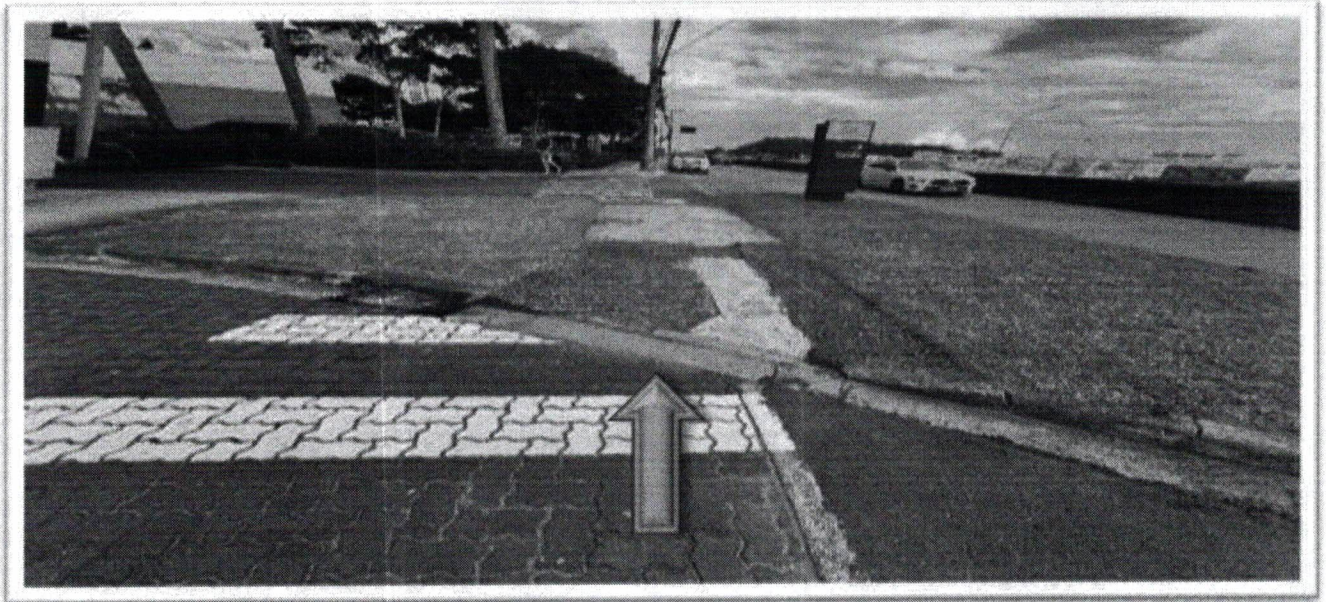
Figura 2 - Rebaixo de guia na calçada externa para acesso à portaria
