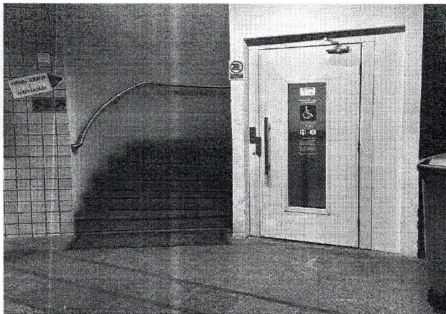
Figura 5 - Elevador acessível Fonte: Autor, 2023
