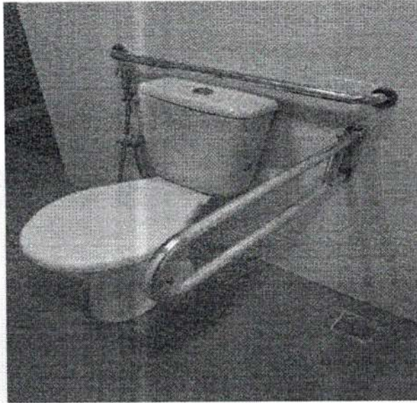
Figura 8 - Banheiro Acessível Fonte: Autor, 2023
